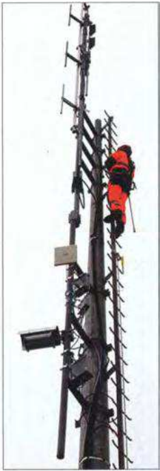
Bild 5: Sendemast am Piz Chavalatsch (2763 m); HD-Foto-Webcam, Datenfunk- und Sprechfunkrelais für 2 m sowie 70 cm finden dort Platz.
